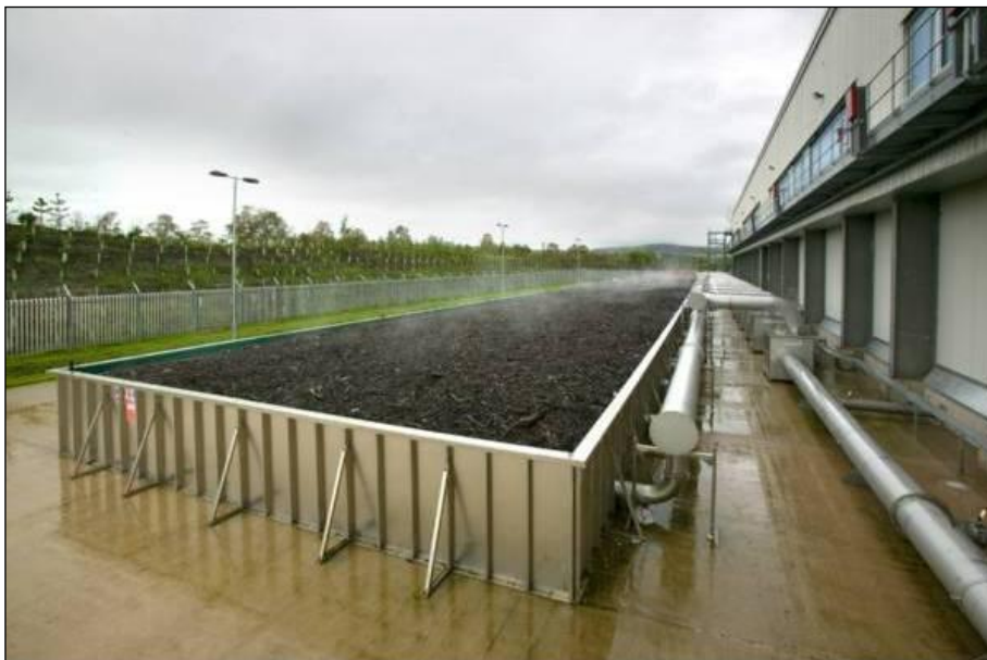
Slika 1.1-13: Biofiltrar za obradu izlazne zračne struje (slika otvorenog biofiltra je simbolična; predviđena je natkrivena izvedba)
